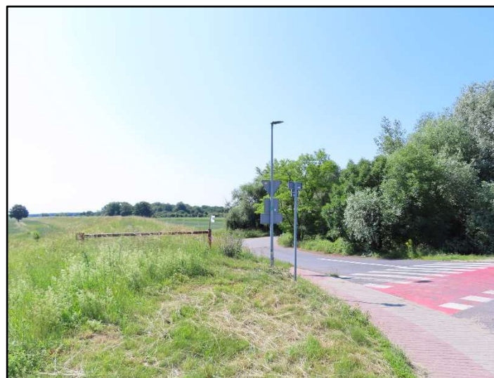
Fot. 4 Wały przeciwpowodziowe na granicy z Piszowicami, gmina Lubiszewo
