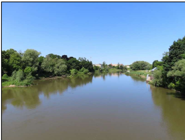
Fot. 22 Odra, widok z mostu na ul. Krakusa w kierunku zachodnim
