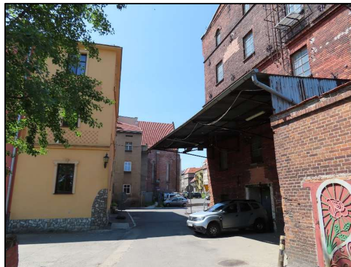
Fot. 43 Stare zabudowania związane z funkcjami portowymi
