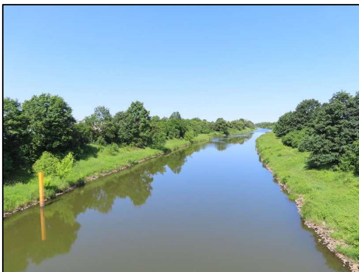
Fot. 14 Kanał Odry, widok w kierunku zachodnim
