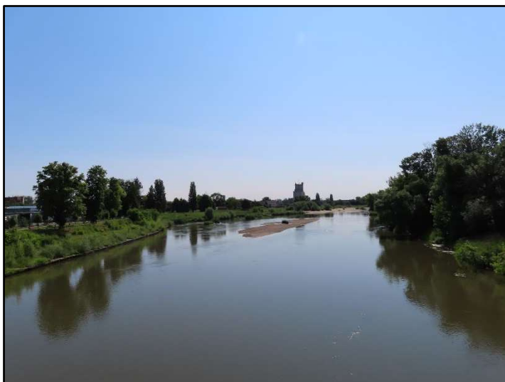
Fot. 1 Widok na Odrę w kierunku wschodnim z mostu na ul. Krakusa
