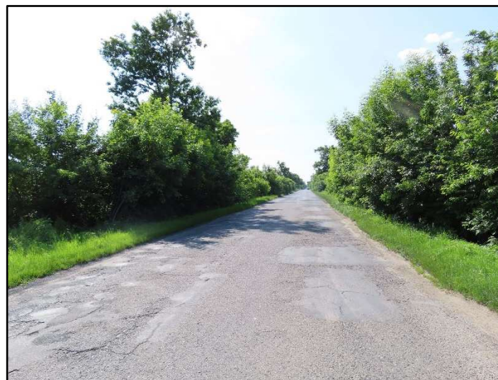
Fot. 78 Wlot do miasta od strony ul. Wrocławskiej, widok w kierunku zachodnim
