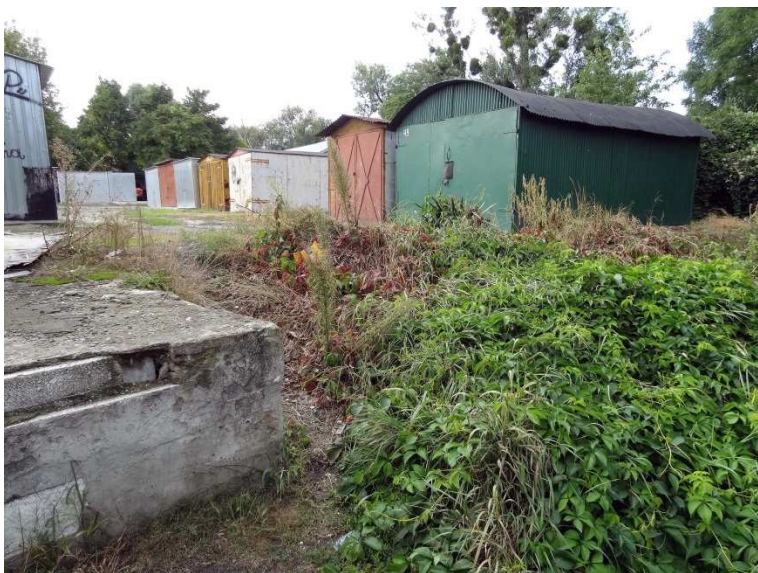
Fot. 19 Zespoły garaży przy zabudowie przy ul. Rybackiej.
