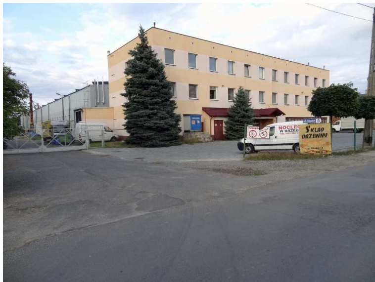
Fot. 9 Zabudowa usługowa przy ul. Grobli
