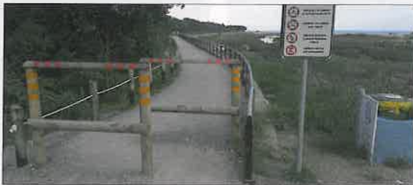
Fot. 9 | Nawierzchnia z kłnca kamiennego
