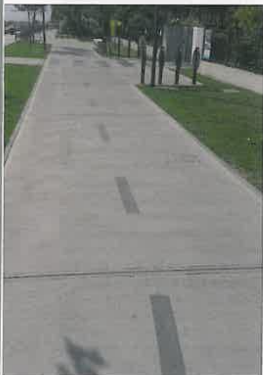
Fot. 2 | Betonowa nawierzchnia ścieżki rowerowej
