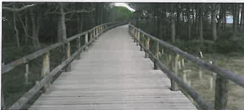
Fot. 8 | Drewniana nawierzchnia ścieżki rowerowej
