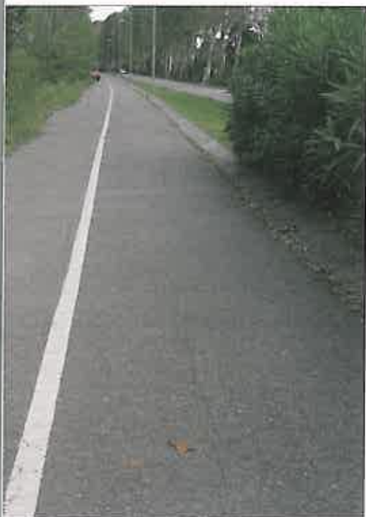
Fot. 1 | Nawierzchnia ścieżki rowerowej wykonana w technologii asfaltu
